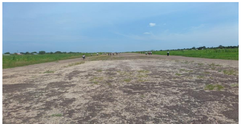
Figure 23: Piste d'atterrissage de l'aéroport national de BANDUNDU
